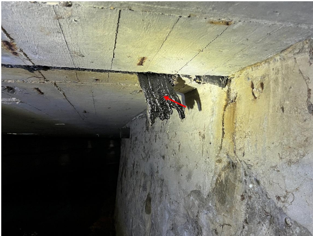
Abbildung 8: Ansicht Fugenmasse im unterirdischen Bereich.
