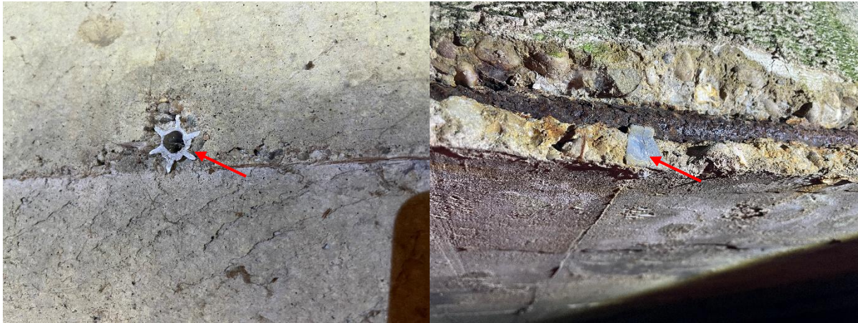
Abbildungen 9 und 10: Vorhandene Abstandhalter sind nicht asbesthaltige, sondern aus Kunststoff.
