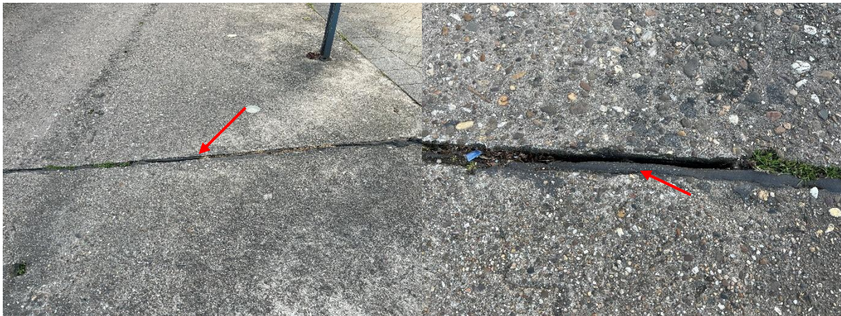
Abbildungen 3 und 4: Ansichten Fugenmassen Bereich Anlieferung Woolworth.
